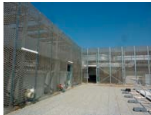
Figura 4 – Particolare delle schermature esterne poste in copertura
