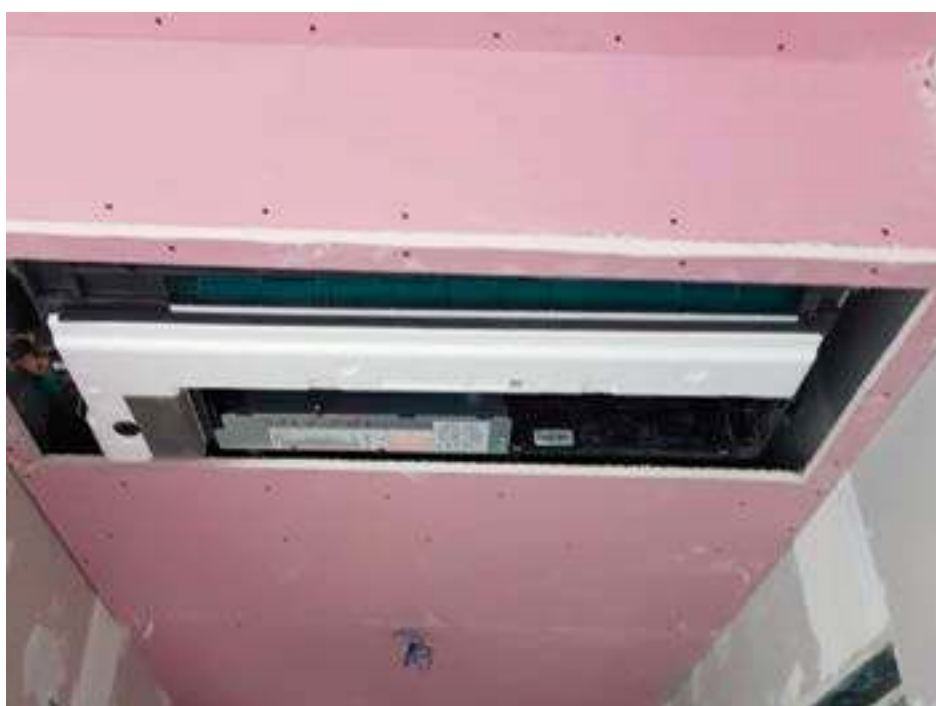
Figura 1- Installazione della cassetta a 1 via
