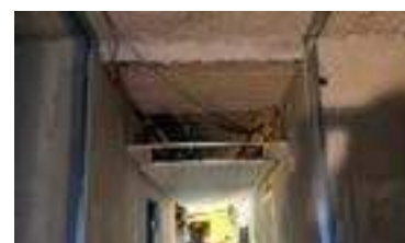
Figura 7 – Hotel The Britannique: passaggio degli impianti nei controsoffitti dei corridoi
