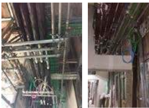
Figura 7 – Hotel The Britannique: passaggio degli impianti nei controsoffitti dei corridoi
