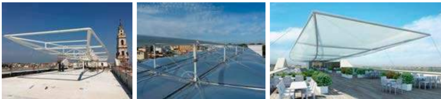
Figura 1 – Hotel Habita 79: la copertura
