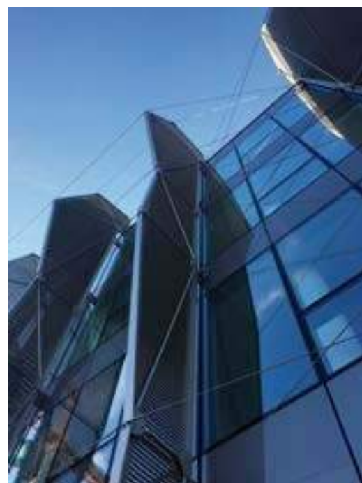
Figura 4 – Dettaglio dei frangisole
