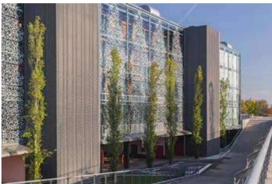
Figura 5 – Facciata sud-ovest dell'edificio
